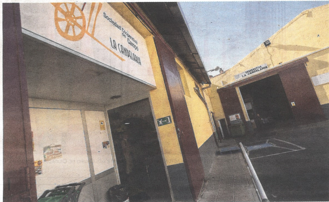
VISTA PARCIAL DE LA SEDE DE LA ENTIDAD EN LA ZONA LAGUNERA DE SAN BENITO, TASADA EN 3,6 MILLONES. FRAN PALLERO
