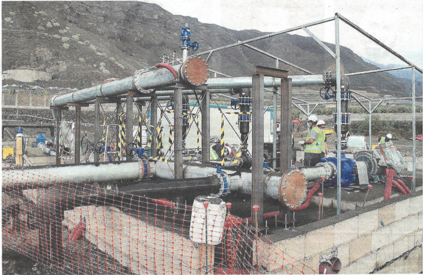
Panorámica de la infraestructura que se ha creado en Puerto Naos, en el municipio de Los Llanos de Aridane. | RAMÓN PÉREZ
